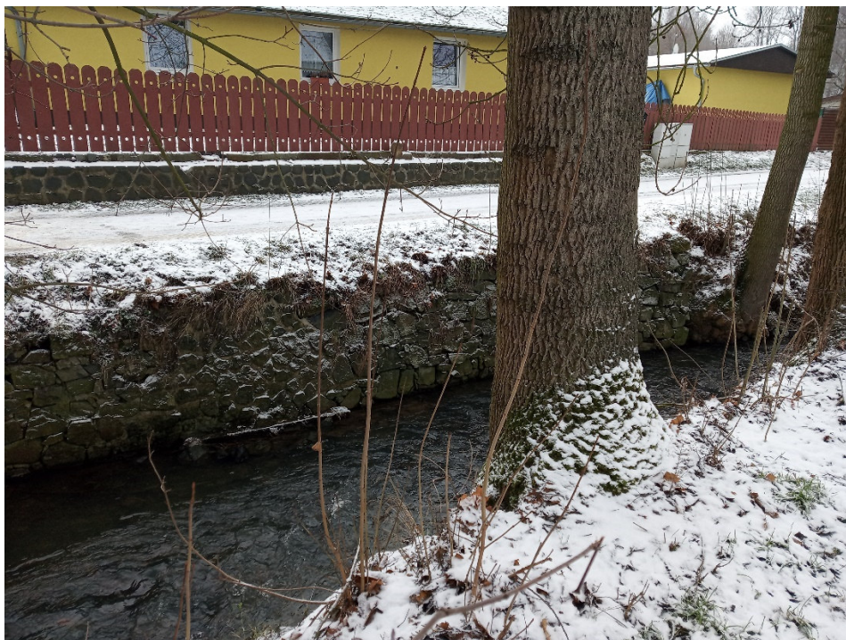
Pohled po toku na stávající opěrnou zeď k rekonstrukci na LB
